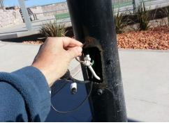
A la derecha del registro se aprecia el tornillo destinado a conectar el conductor con el a r b o t a n t e . Lamentablemente es tipo "pija" lo cual tampoco está permitido por la norma NOM 001 SEDE vigente.
